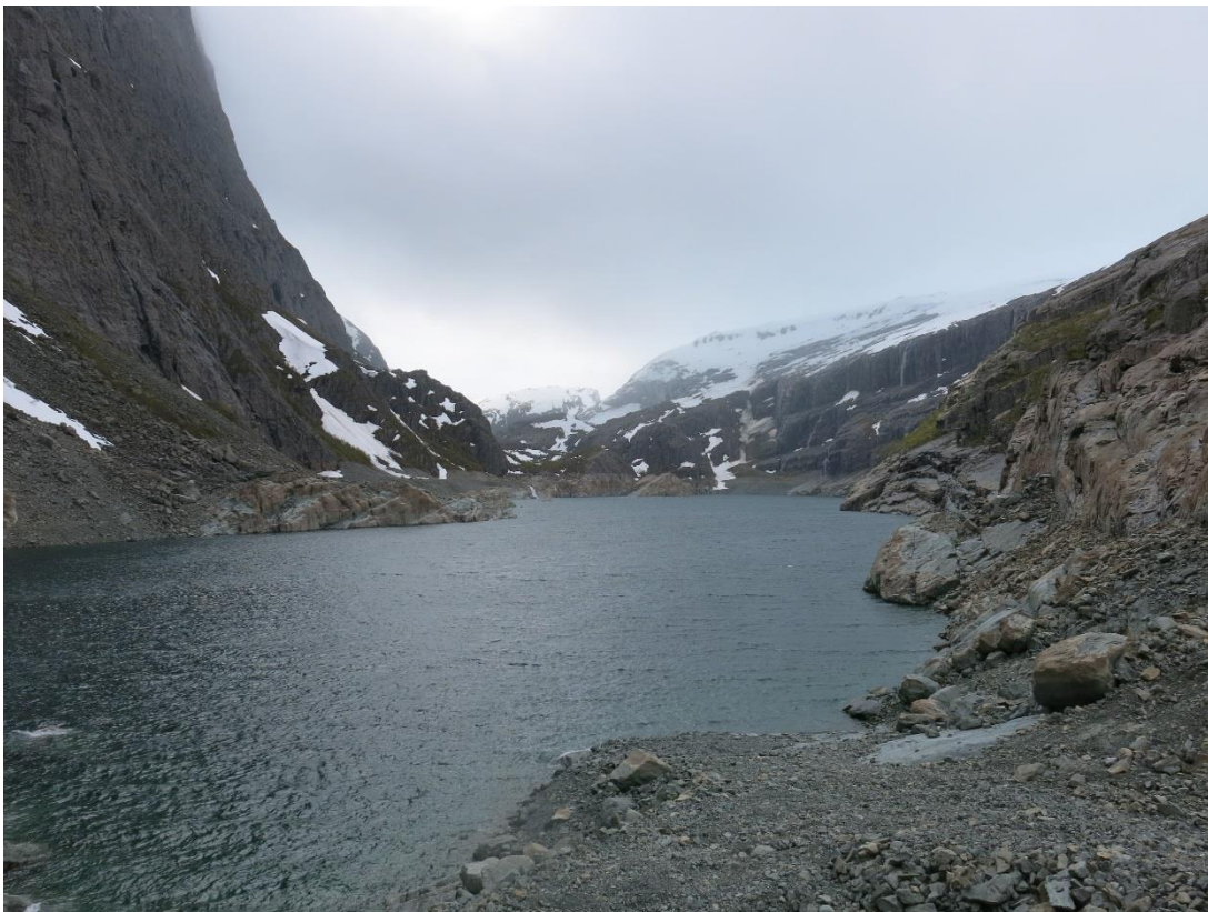
Bilete 4. Reguleringsmagasinet Bjørndalsvatnet ligg utanfor verneområdet, men fjella lengst i bakgrunnen er innanfor Ålfotbreen landskapsvernområde.
