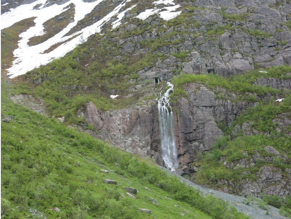
Bilete 7. Overføringstunnel og helikopterlandingsplass i fjellsida over Litle Åskorvatnet. Foto: Alf Rik Røyrvik
