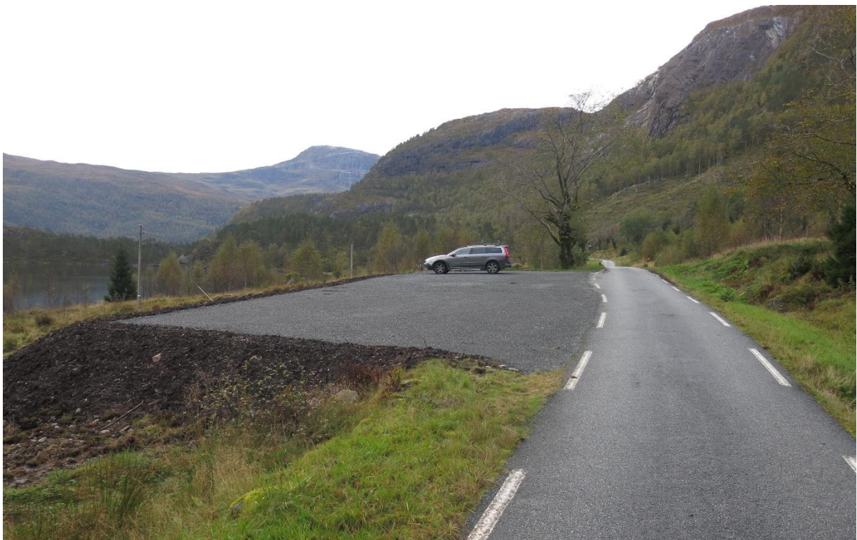
Bilete 10. Den opprusta og utvida parkeringsplassen i Grøndalen. Vi har fått krav om å avgrensa avkjørsla frå fylkesvegen. Dett skal gjerast i 2024.
