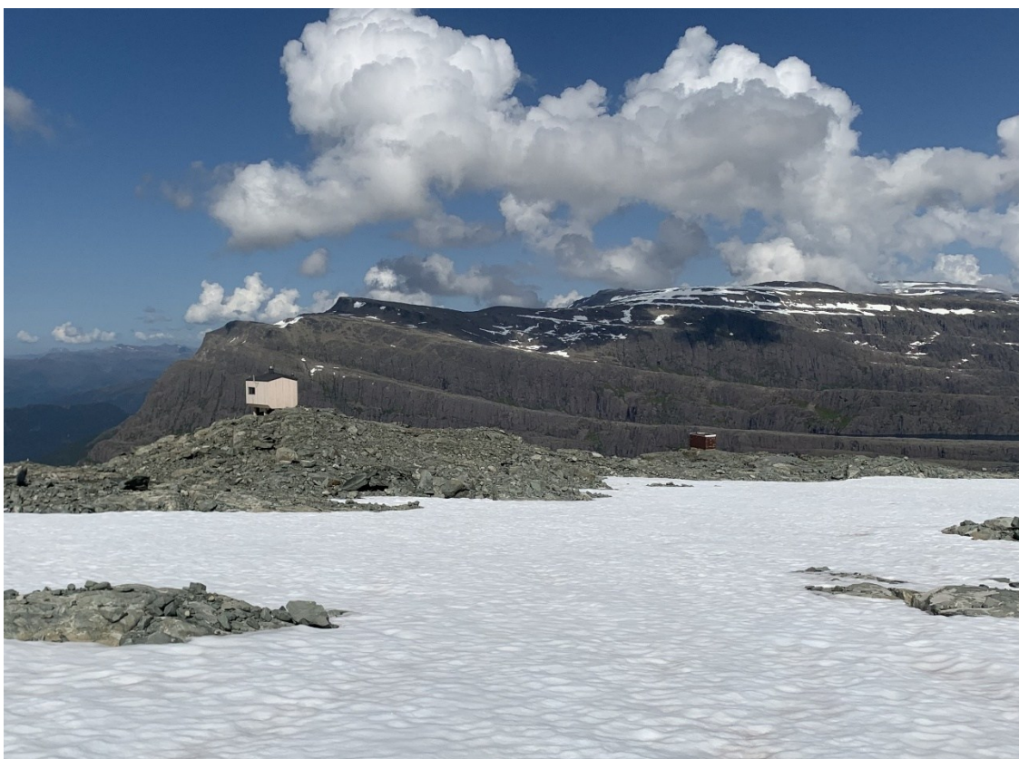
Bilete 5 og 6. Den nye bremålingshytta til SFE og NVE nord for Ålfotbreen. På nedste biletet ser du og den gamle brakkehytta som hytta skal erstatte. I tillegg erstattar den ein stålkontainar som allereie er fjerna. Foto: SFE
