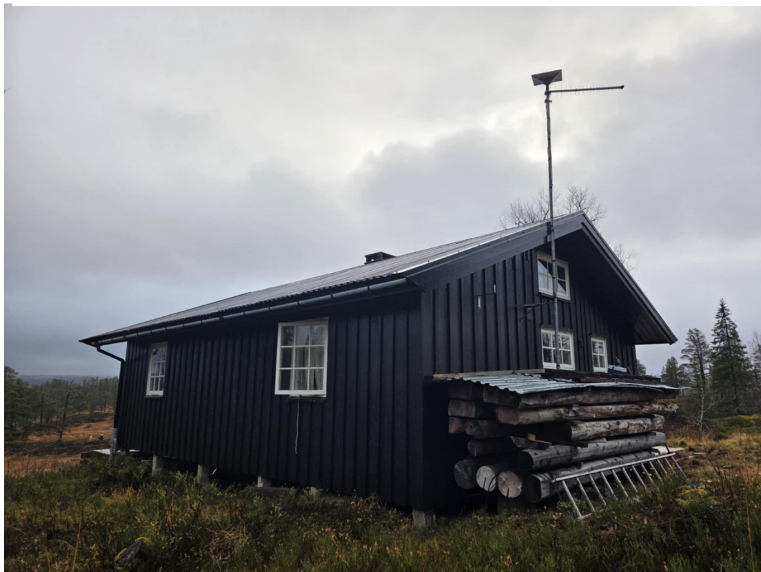
Figur 2 Hytte fra nord. Her ønskes det å skifte ut eksisterende vinduer og sette inn to nye vinduer – et i samme størrelse som de øvrige (1200 × 1000 mm) og ett litt mindre (1200 × 600 mm). Alle vinduene skal ha sprosser. Hytta bygges ut på kortenden med overbygg.
