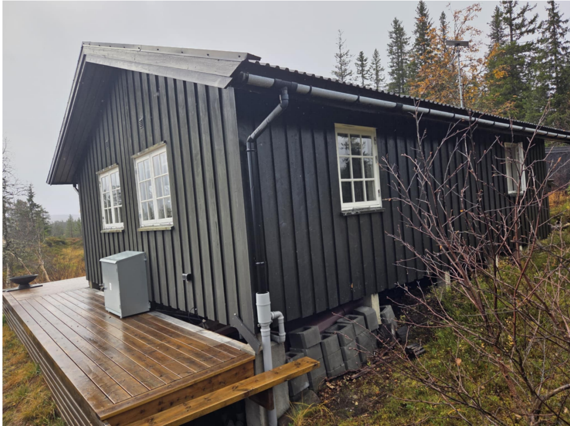
Figur 4 Hytta fra øst. Vinduene på den østlige vegg (kortenden) ønskes skiftet ut med fire større vinduer, målt til 1000 \times 1800 mm, uten sprosser.
