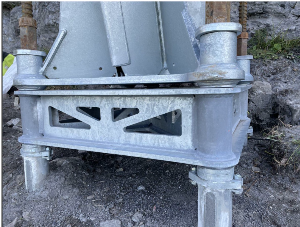
Figur 16: Fundament skredtårn, med tårn montert. Etter endt prosjekt kan fundamentet kappes helt nede ved bakken etter at tårn og stålramme er fjernet. Foto: Wyssen.
