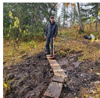
Rehabilitering og sklisikring av kloppe på Namskrokstien 2025
