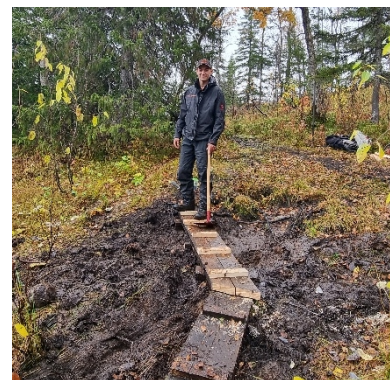
Rehabilitering og sklisikring av kloppe på Namskrokstien 2025
