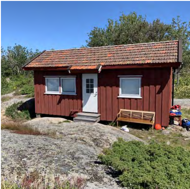
Figur 1: Eksisterende annekset, fasade mot sørvest
