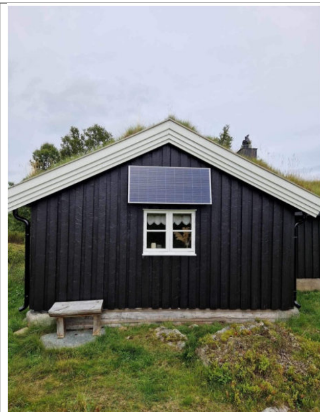
Figur 2: Fasade sørøst, søknad om erstatning av vindu til terrassedør.
