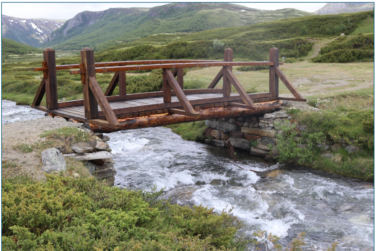
Ny bru på den gamle setervegen i Grimsdalen landskapsvernområde – del av Barthstien. Foto: Rondane-Dovre nasjonalparkstyre
