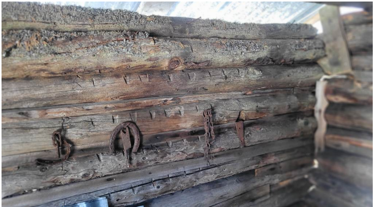
Innvendig søre langvegg. Merking/ nummerering
