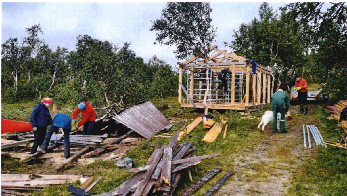
Dugnad: det gamle naustet rives, og det nye settes opp like bak. Foto: Eskil Følstad, TT.
