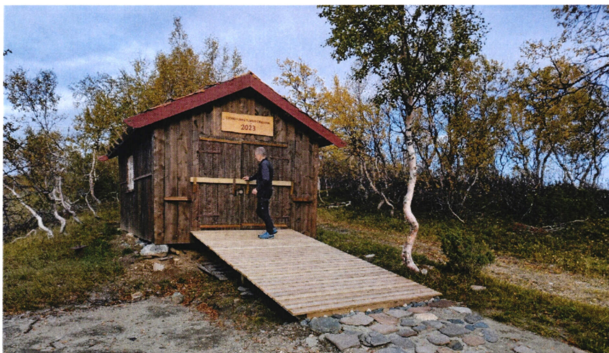
Det nye naustet ferdig høsten 2024. Tomta til det gamle naustet nede til venstre. Planen er å olje den nye lunnbrua mørk brun, som naustet. Foto: Eskil Følstad, TT.
