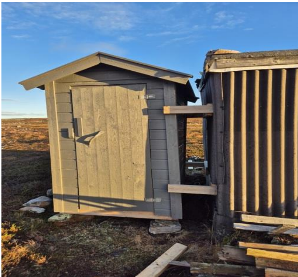
Toalett etablert på bua Stormheim/ Huhtircohat i 2024
